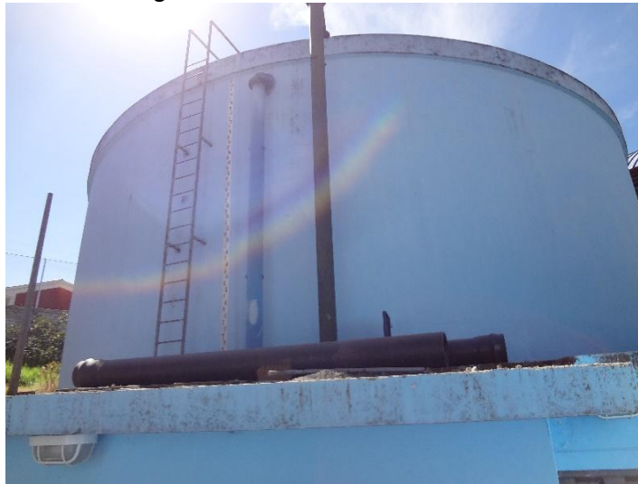
Imagen N° 25: Vista del Reservorio Díaz Barcenas
