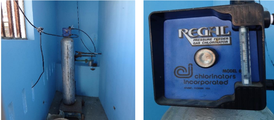
Imagen N° 22: Vista del sistema de cloración
