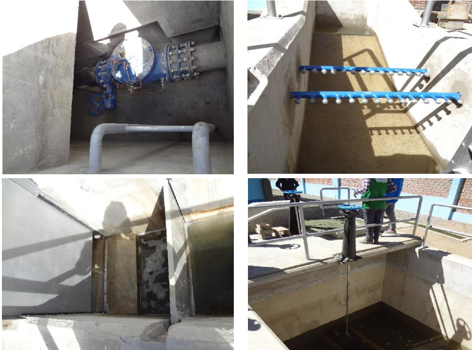
Imagen N° 37: Vista de Reservorio PTAP Puruchaca
