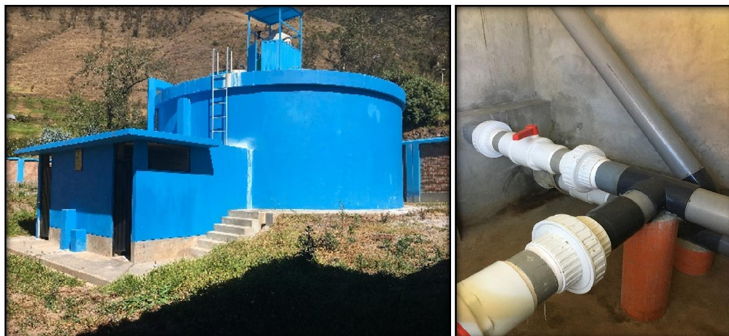
Fuente: Visita de campo 21/06/2019 Elaboración: Dirección de Regulación Tarifaria (DRT) – SUNASS
