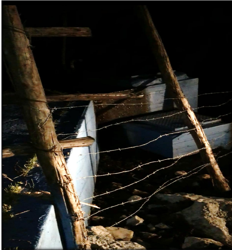
Fuente: Visita de Campo a la localidad de Chalhuanca. Fecha: 17/06/2019 Elaboración: Dirección de Regulación Tarifaria (DRT) – SUNASS
