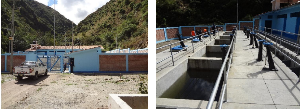
Imagen N° 36: Vista de PTAP Puruchaca
