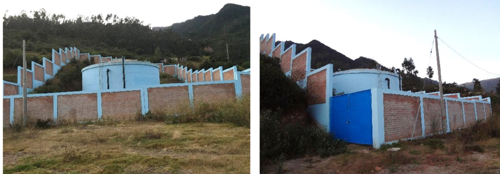
Imagen N° 32: Vista de Reservorio León Pampa
