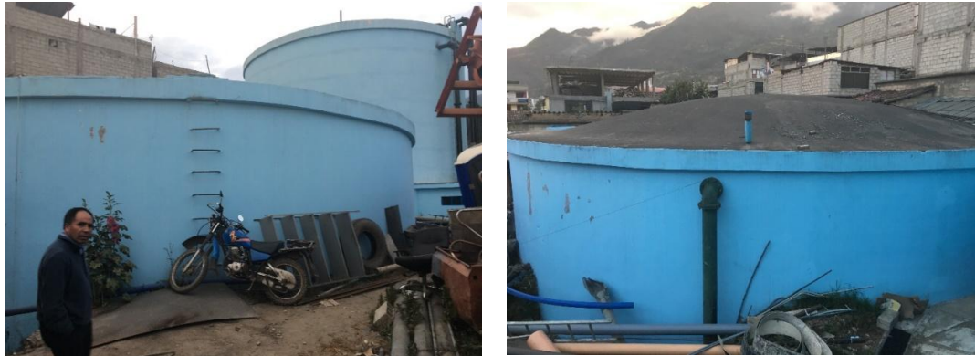
Imagen N° 15: Vista del Reservorio El Prado II
